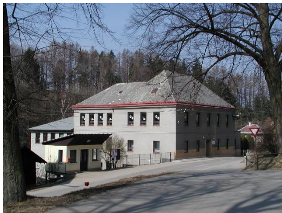
Obr. 121. budova ZŠ před zateplením
