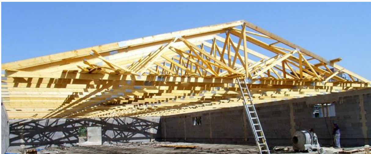
Obrázok 5 názorná ukážka drevených priehradových nosníkov
