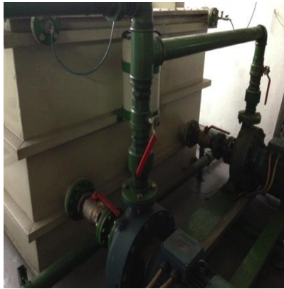
Obr. 23 Nádrž s vodou
