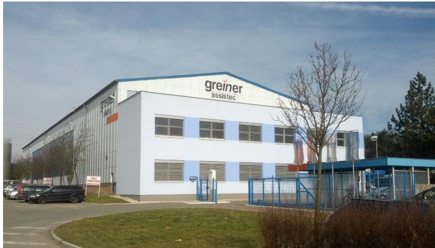
Obr. 15 Společnost greiner assistec s.r.o. (Vlastní zpracování)
