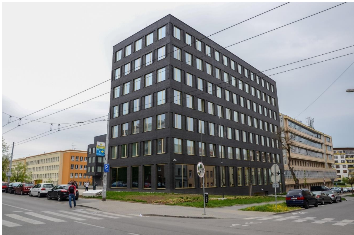
Obr. 1: Budova CERIT [vlastní zdroj]
