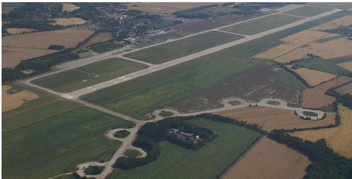
Obr. 7. Letecký pohled na areál letiště Leoše Janáčka v Ostravě [Zdroj: vlastní]
