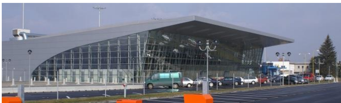
Obr. 9. Pohled na nový letištní terminál, který byl dokončen v roce 2008 [Zdroj: 11]
