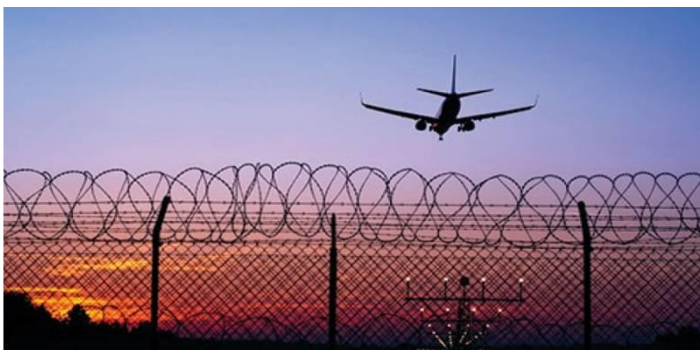
Obr. 4. Oplocení areálu letiště doplněné vrcholovou zábranou [Zdroj: 3]
