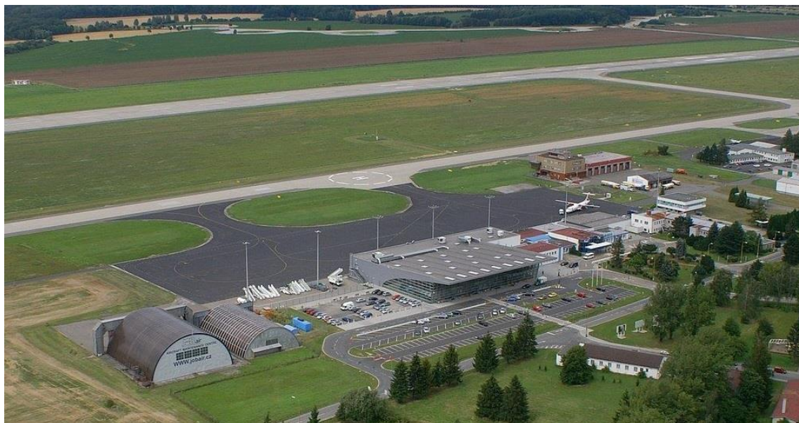
Obr. 8. Servisní centrum JOB AIR, letištní terminál a parkovací plocha [Zdroj: 14]
