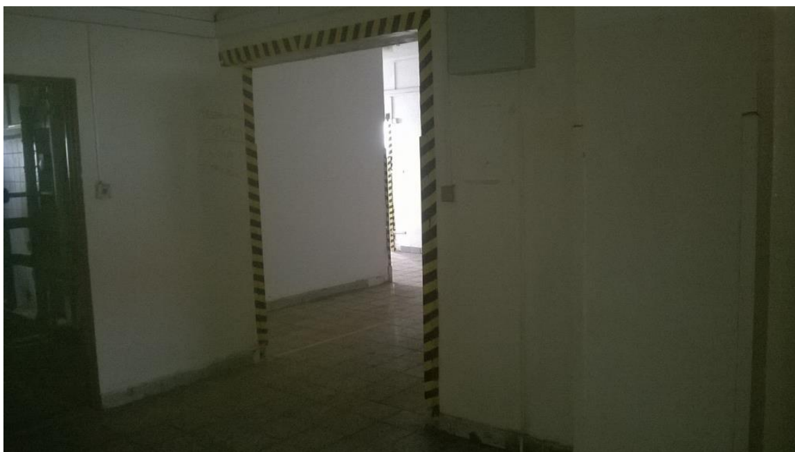
Obr. 15 Vstup produkce 1.NP – jednokřídlé dveře min. RC4; ovládané ACS [Zdroj: vlastní]
