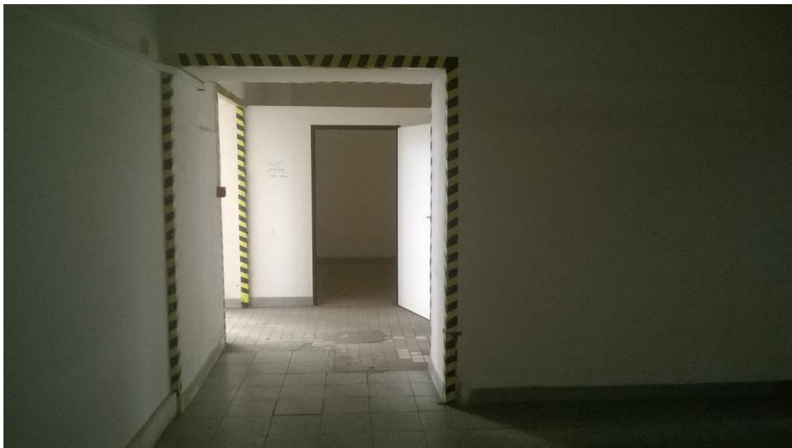
Obr. 14 Vstup produkce 2.NP – jednokřídlé dveře min. RC4; ovládané ACS [Zdroj: vlastní]
