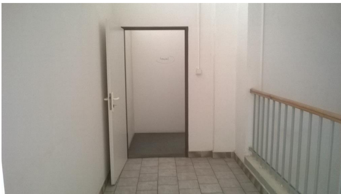
Obr. 13 Vstup administrativní úsek – jednokřídlé dveře min. RC3; ovládané ACS [Zdroj: vlastní]
