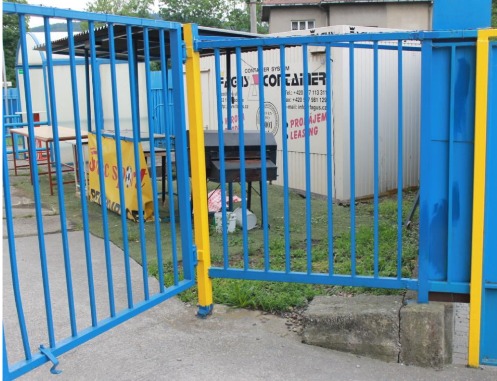
Obr. 13 Nedostatočná zábrana k nepovolenému vstupu na tribúnu [Jan Zahnaš]
