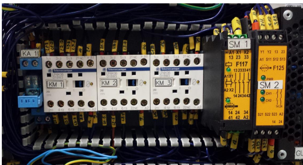
Obr. 37. Prostřední řada komponent rozvaděče
