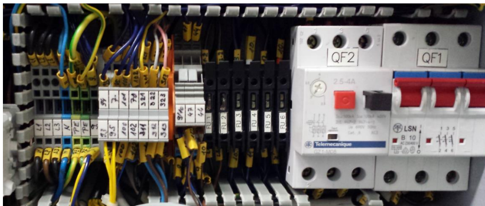
Obr. 36. Spodní řada komponent rozvaděče
