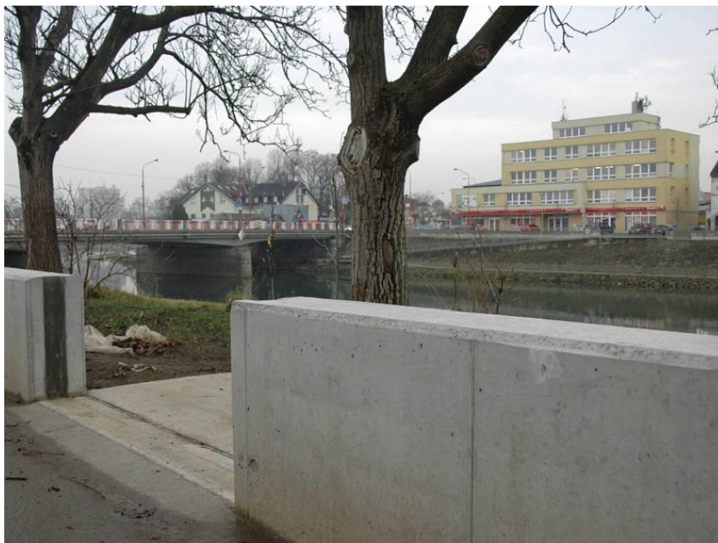
Obrázek 9 Protipovodňové železobetonové zídky u řeky Moravy
