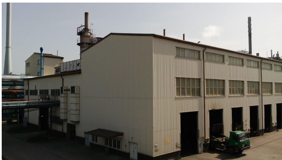
Obr. 3. Spalovna průmyslových odpadů DEZA Valašské Meziříčí
