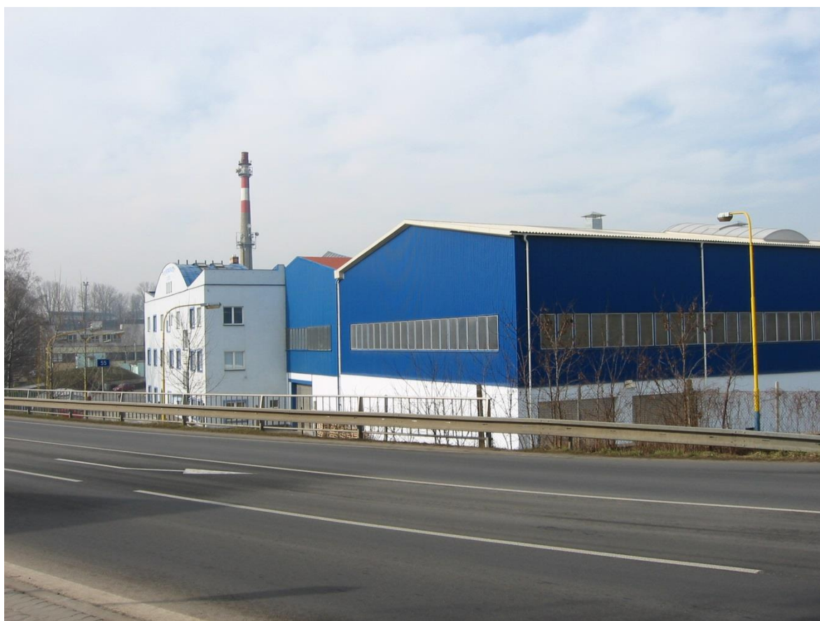
Obrázek 13: Pohled na areál Tažírny oceli TŽ, a. s. (vlastní zpracování)
