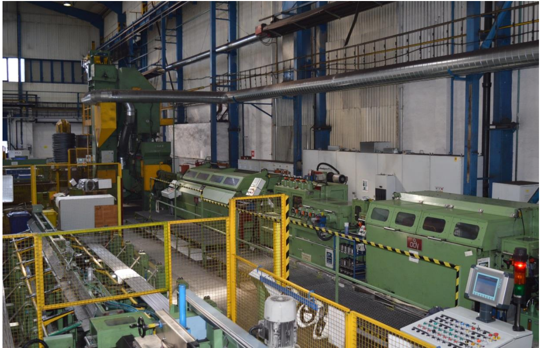
Obrázek 20: Pohled na KTS_0 (vlastní zpracování)
