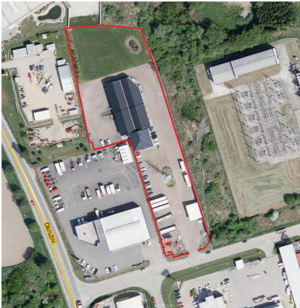
Obr. 25 Zabezpečovaný objekt označený červeně [26]
