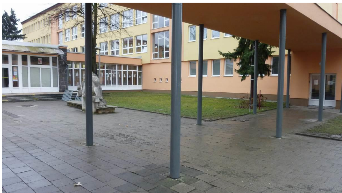
Obr. 18 Vchod do školní jídelny
