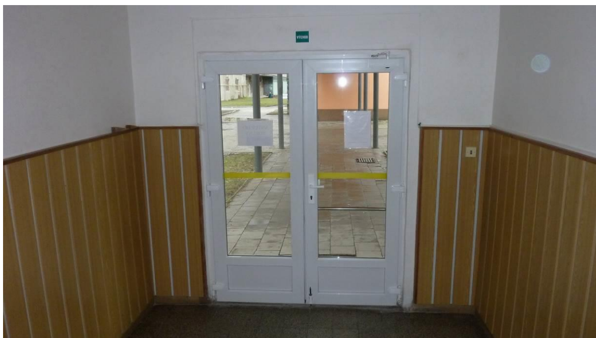
Obr. 19 Vchod do školní jídelny z vnitřní části
