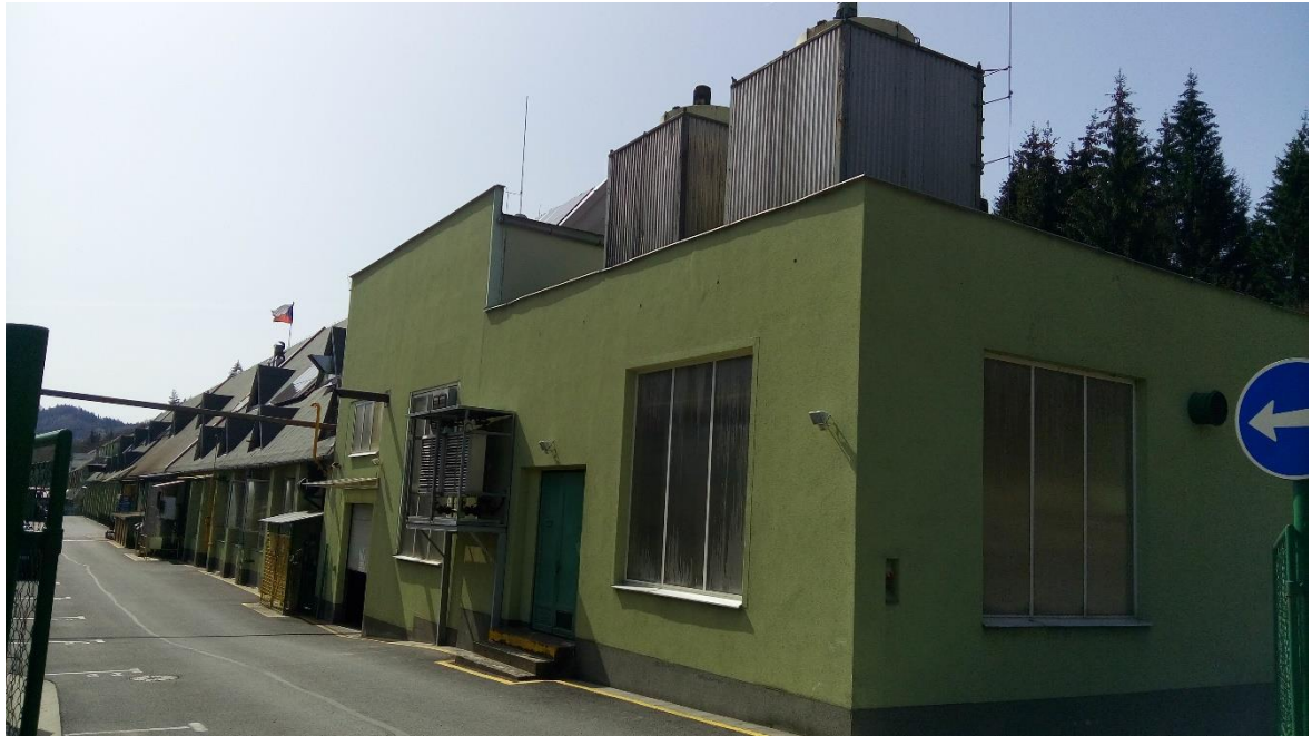
Obrázek 14 Pohled ze severní strany
