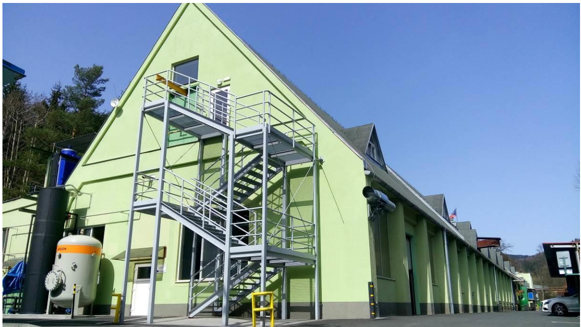
Obrázek 15 Pohled z jižní strany
