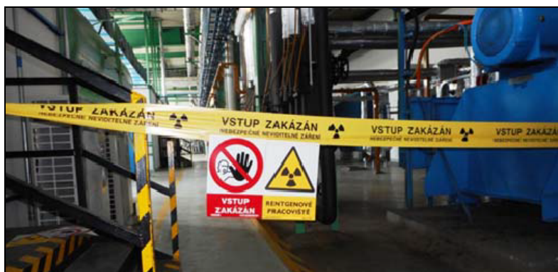
Obr. 17. Přechodné kontrolované pásmo v jaderné elektrárně Dukovany
