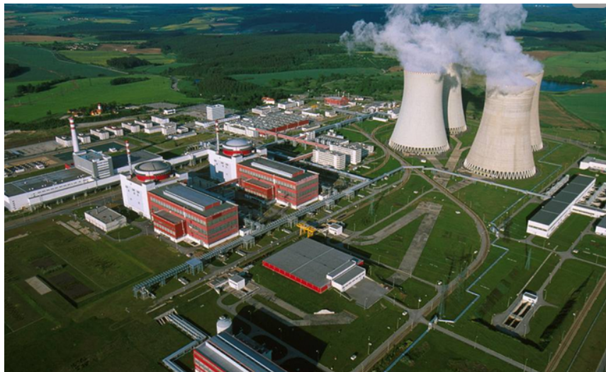
Obr. 4. Celkový pohled na areál jaderné elektrárny Temelín
