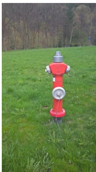
Obrázek 9 Požární hydrant v blízkosti domu [Zdroj: vlastní]
