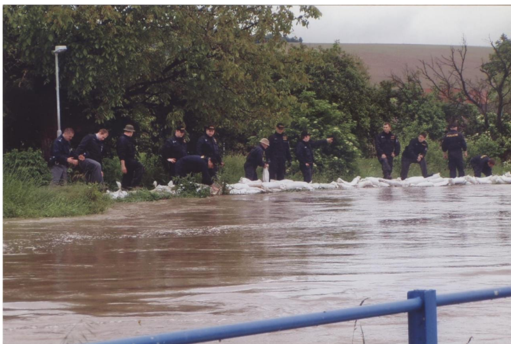
Obrázek 10: Stavba hrází z pytlů s pískem v roce 2010
