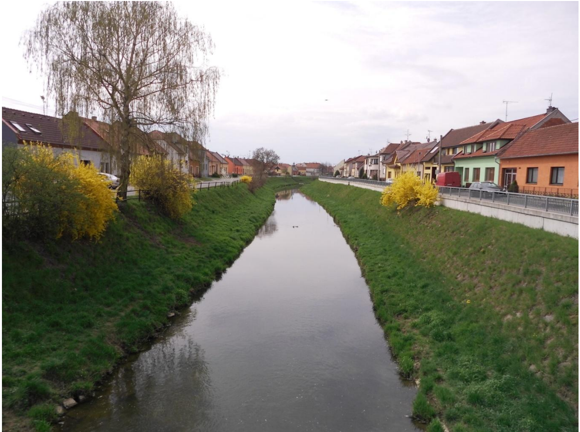
Obrázek 5: Stav koryta na jaře 2016 na řece Olšavě
