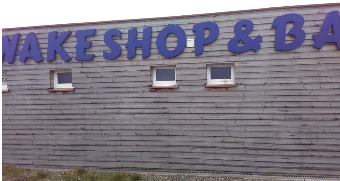
Obrázek 5: Okenní ventilace, kterými je možné vniknout do budovy
