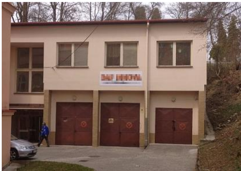
Obr. 9. Budova firmy. Vlastní fotografie
