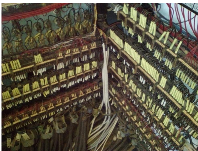
Obr. 16: Rozvody ve druhé rozvodně
