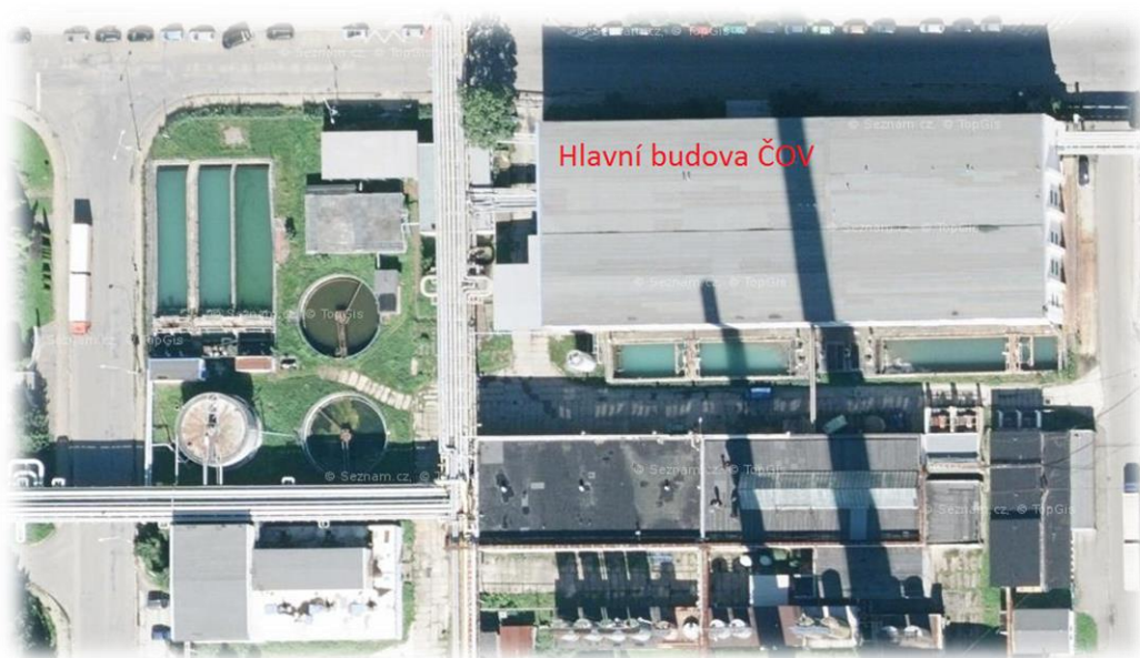
Obr. 12: Areál čističky odpadních vod
