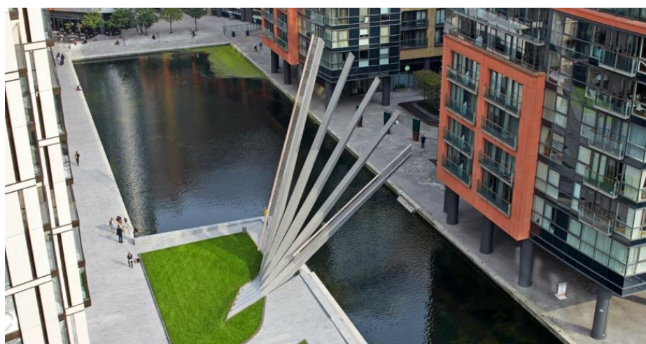
Obr. 22: Fan Bridge, Paddington Basin, Londýn (Velká Británie)
