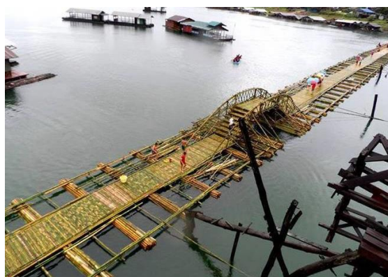
Obr. 16: Náhrada za Mon Bridge, Sangkhlaburi (Thajsko)
