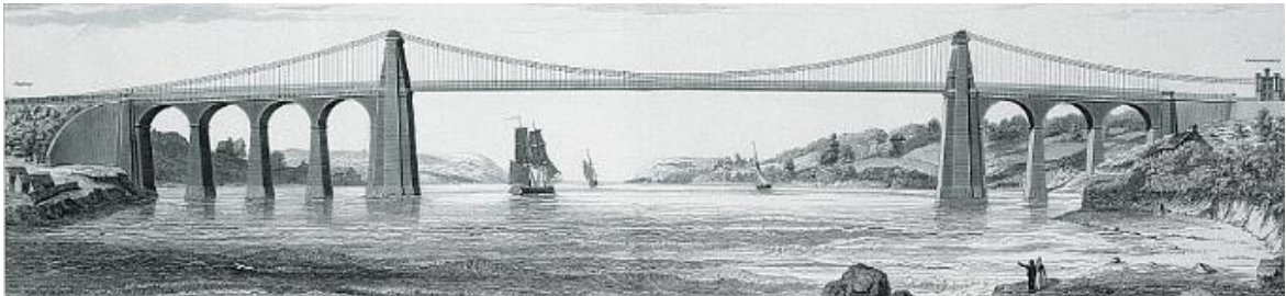
Obr. 4: Most přes úžinu Menai, Thomas Telford
