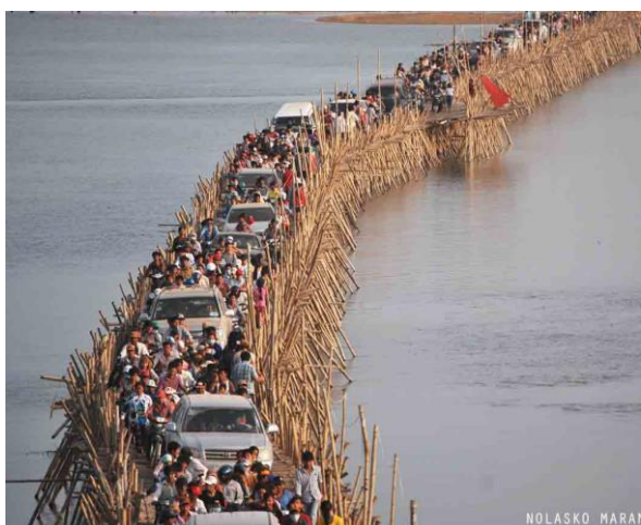
Obr. 13: Bambusový most, Kampong Cham (Kambodža)
