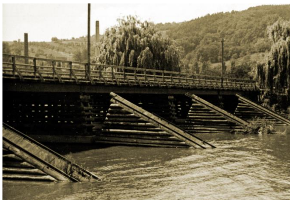
Obr. 37: Provizorní most (Foto: František Cívla)
