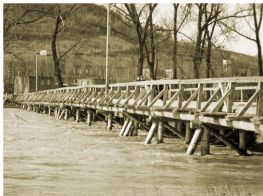
Obr. 38: Provizorní most (Foto: František Cívla)
