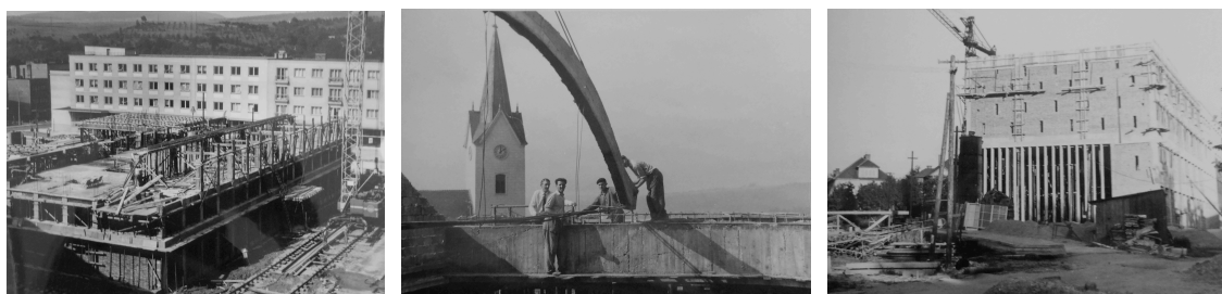
Obr.65., Obr.66. a 67. Fotodokumentace stavby
