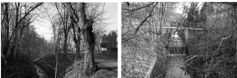
Obr.100. Přítok potoka do Kudlovské přehrady, Obr. 101. Koryto Kudlovského potoka
