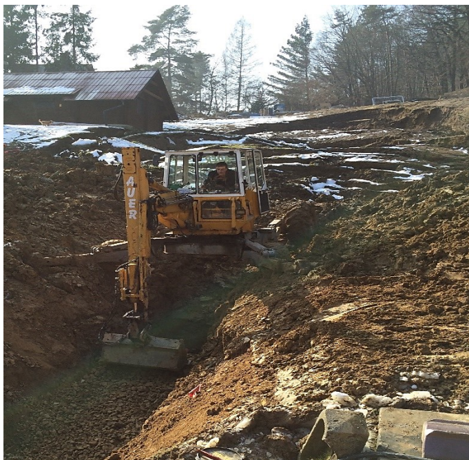
Obr. 10 Sanace svahů, zdroj: vlastní zpracování
