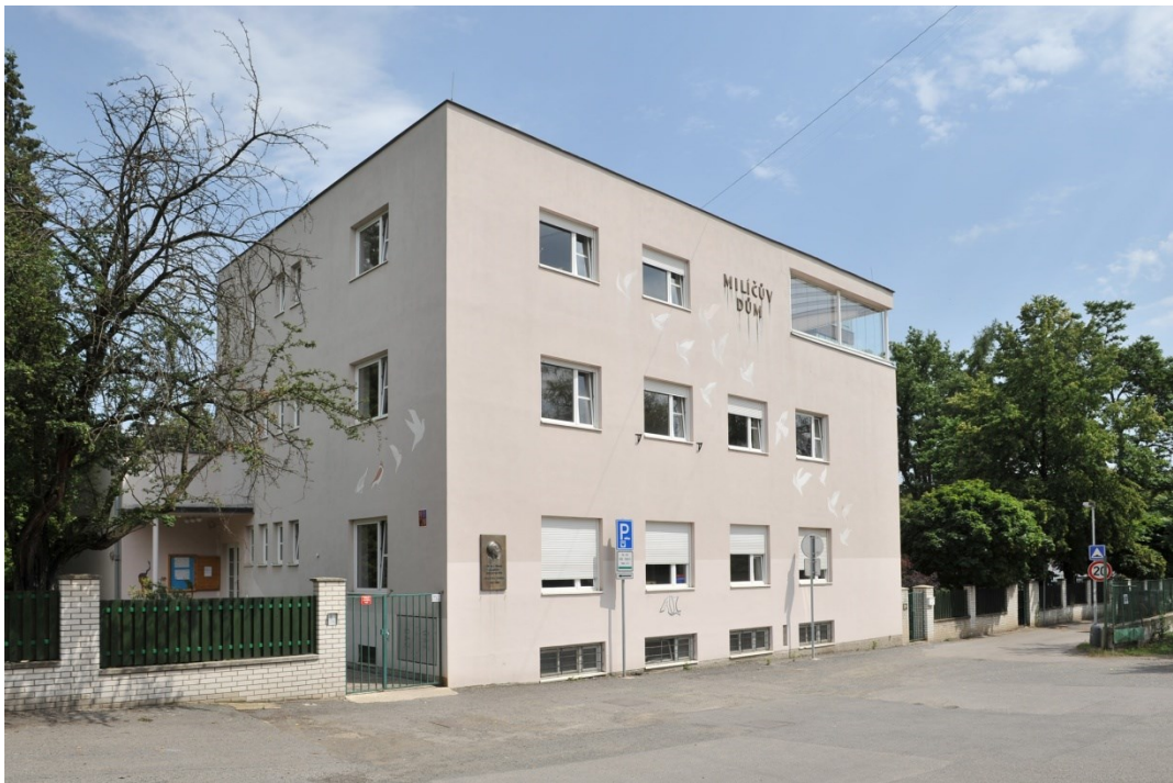
Obr. 5 Milíčův dům v současnosti. Od roku 1976 slouží jako mateřská škola
