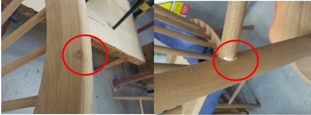
Špatně zatmelená dírka
