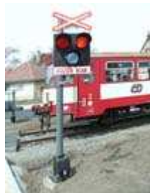
Obr. 15. Traťová zabezpečovací zařízení AH [18]
