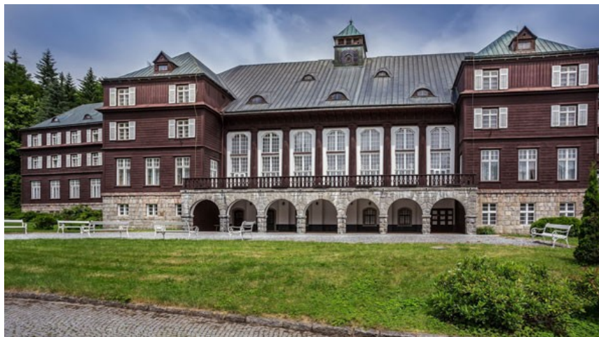
Obrázek 13 Lázeňská budova Libuše
