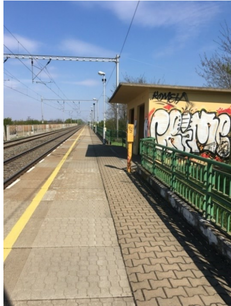
Obrázek č. 13 – Současný stav železniční zastávky (zdroj: vlastní fotografie)
