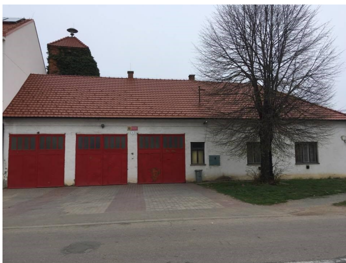
Obrázek č. 10 – Současný stav budovy hasičské zbrojnice 1
