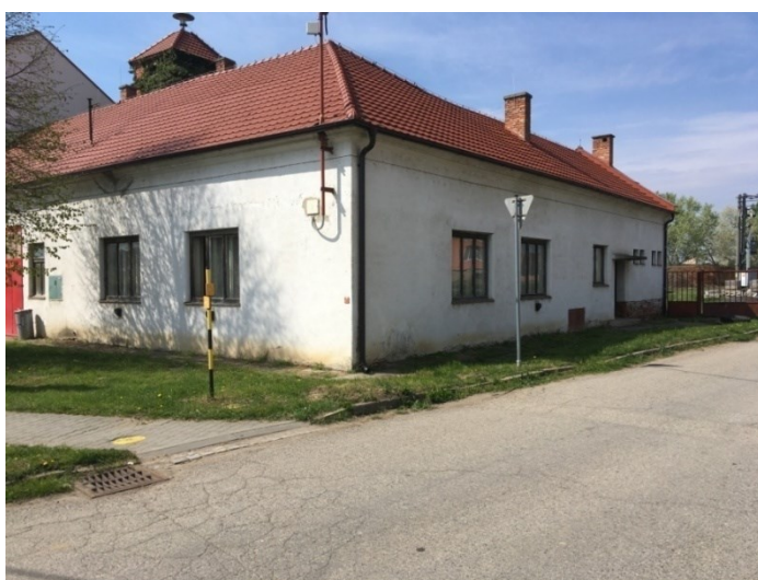
Obrázek č. 11 – Současný stav budovy hasičské zbrojnice 2
