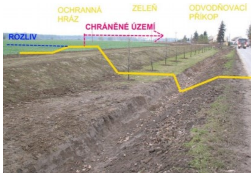
Obr. 25. Návrh ochranné hráze.[23]
