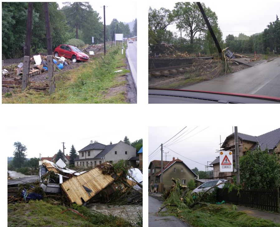
Obr. 5. Místní část Bludovice zasažená povodněmi.[17]
