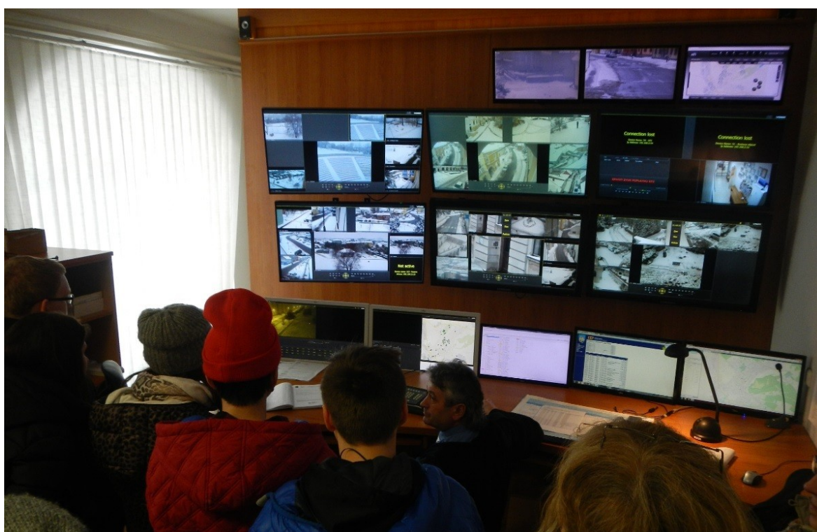
Obr. 5. Monitorovací pracoviště MKDS [30]
