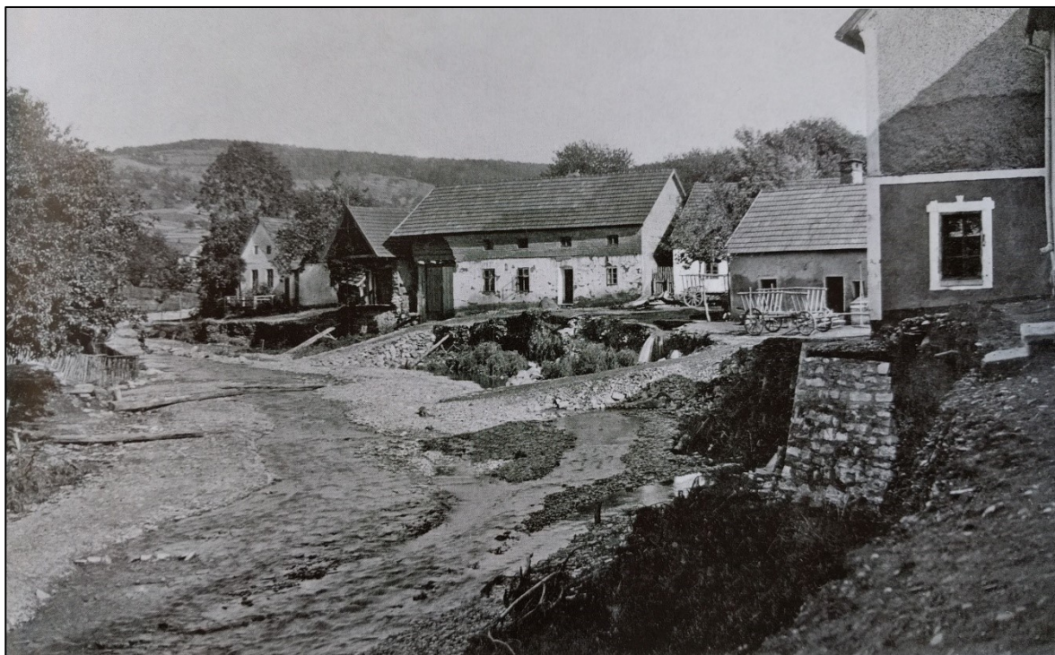
Příloha 9: Následky po povodni 1919, Pitín (Čoupek, 2015).
