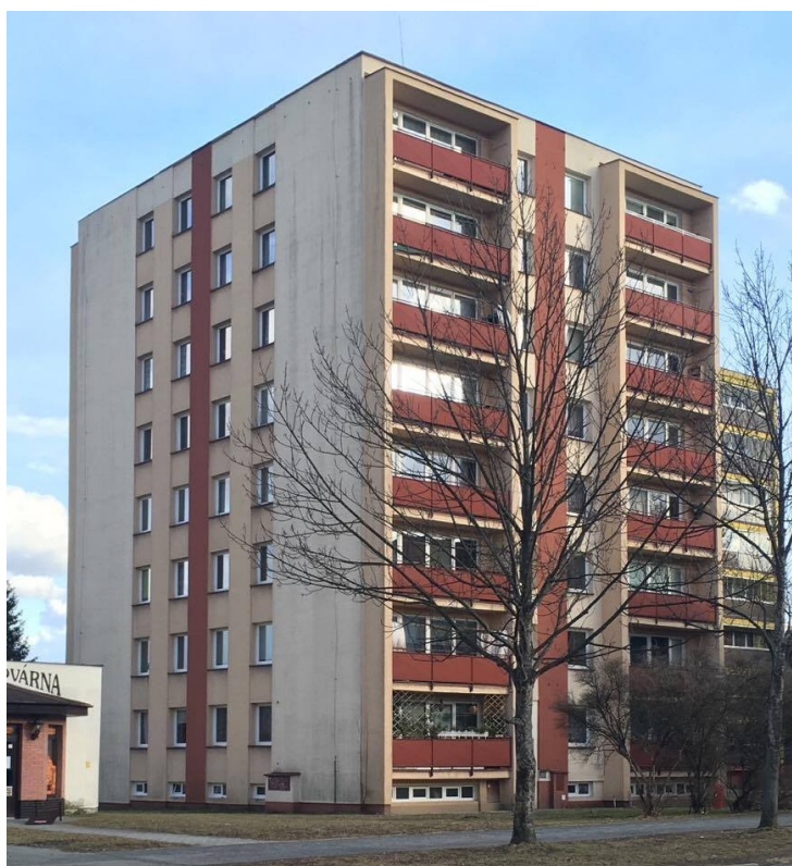
Obrázek 14 – Panelový dům s ochranným prostorem,
