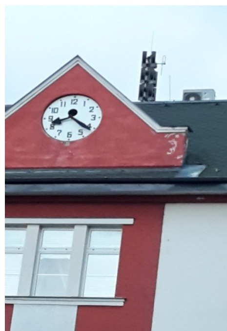
Obrázek 5 Elektronická siréna umístěna na Komerční bance ve městě Rýmařov. [Zdroj: Vlastní]
