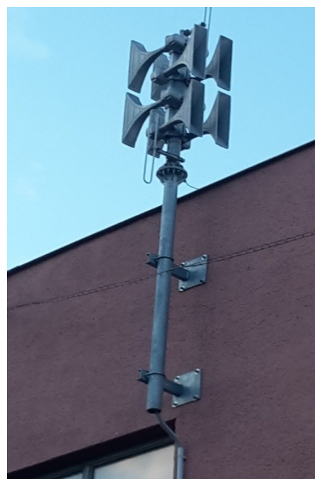
Obrázek 3 Elektronická siréna u technických služeb ve městě Rýmařov. [Zdroj: Vlastní]
