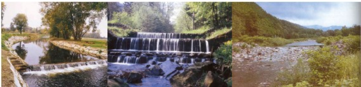
Obr. 7: Stabilizační prvky – práh, stupeň, skluz
