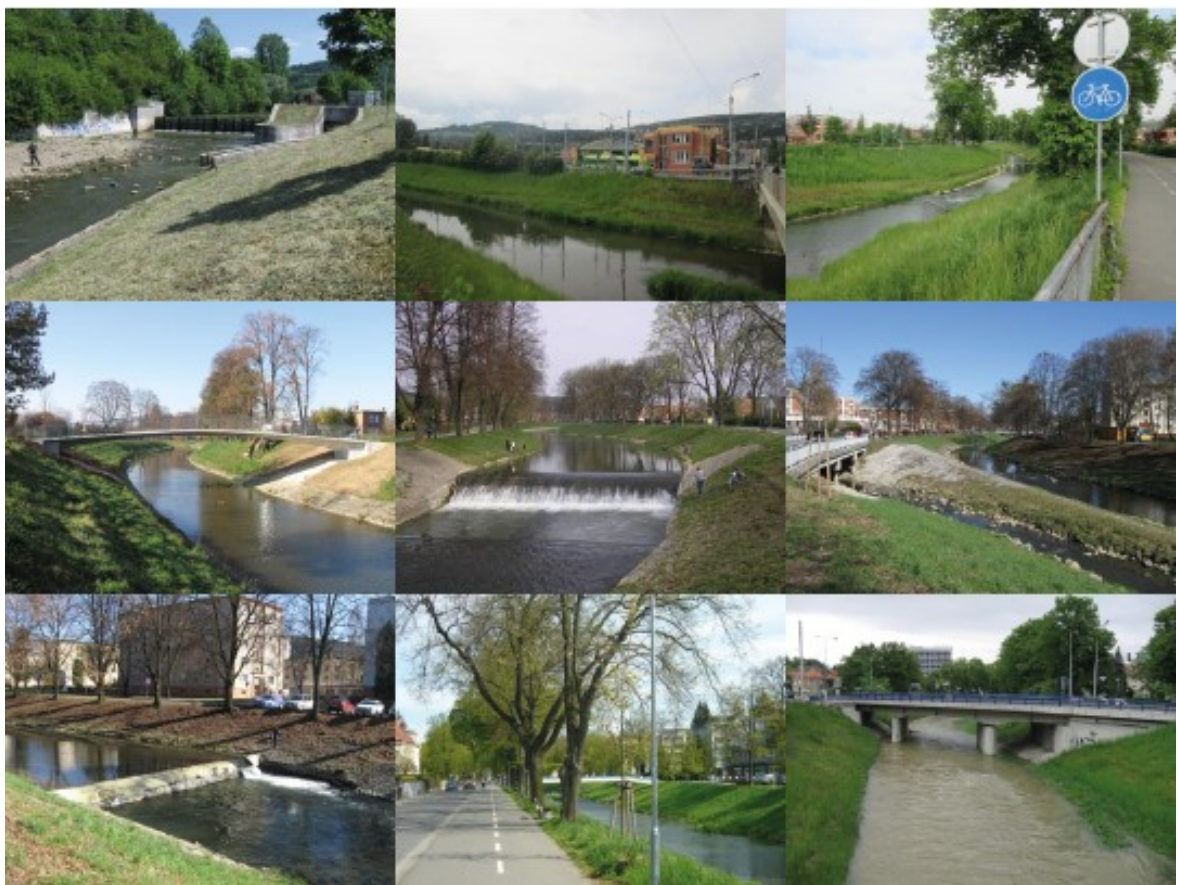
Obr. 8: Dokumentace průtoku Dřevnice Zlínem
