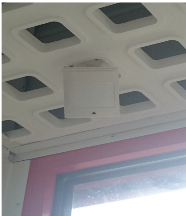
Obr. 15. Montáž PIR detektoru
