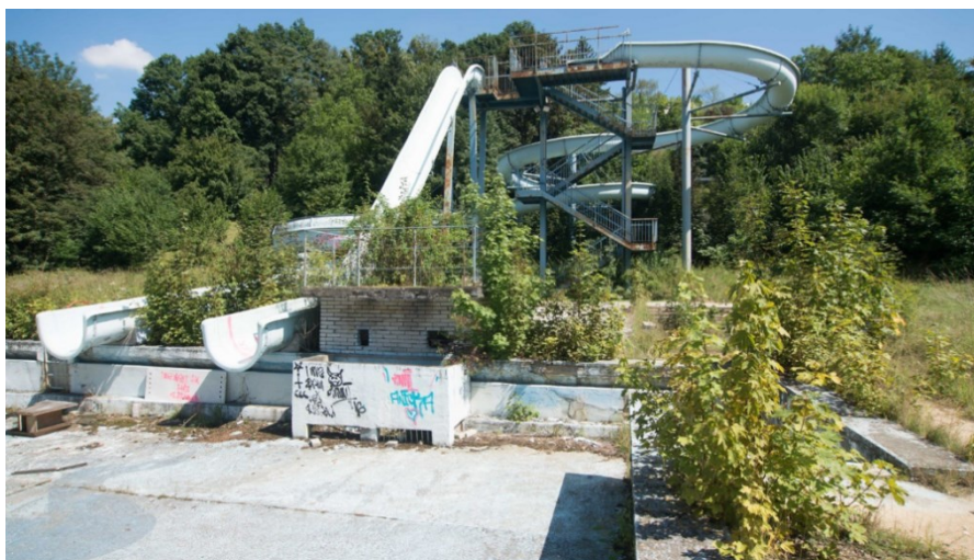
Obr. 4. Současný stav koupaliště Riviéra (Němec, ©1999–2018)
