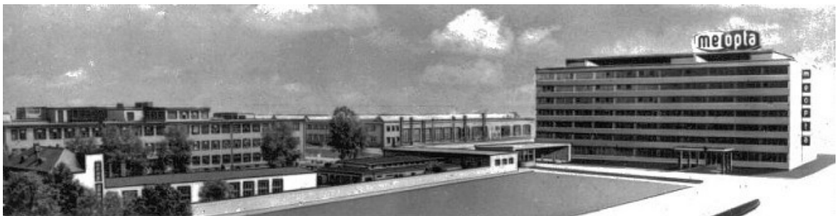
Obr.1 Budova společnosti Meopta v Přerově
