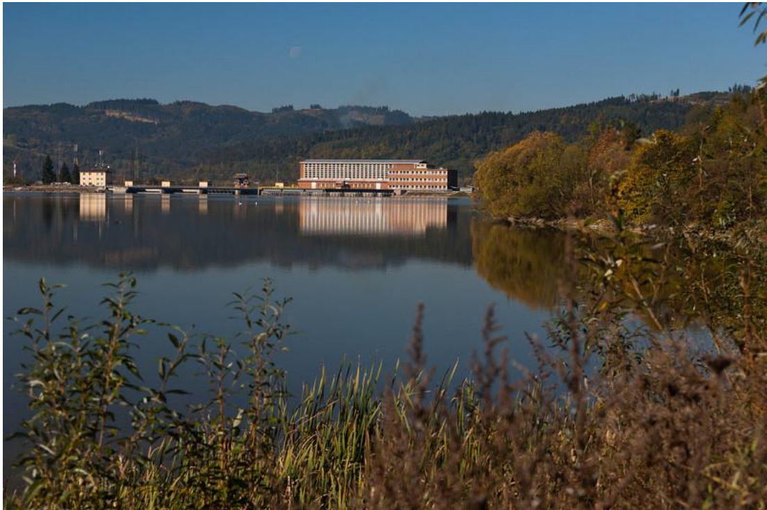
Obr. 11 Vodná elektrárň Hričov [35]
