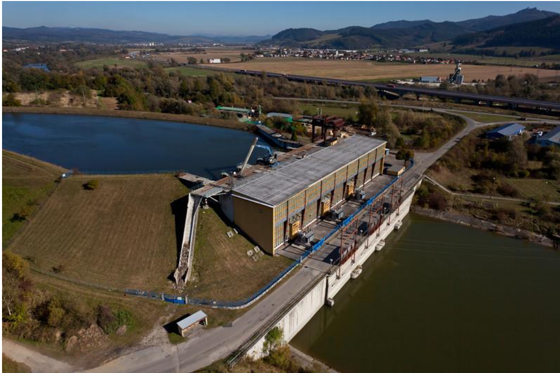
Obr. 12 Vodná elektrárň Mikšová [36]
