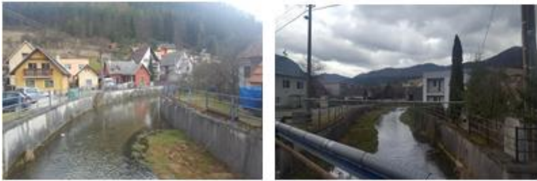
Obr. 19 Úprava toku na území obce Prečín [Zdroj: vlastný]
