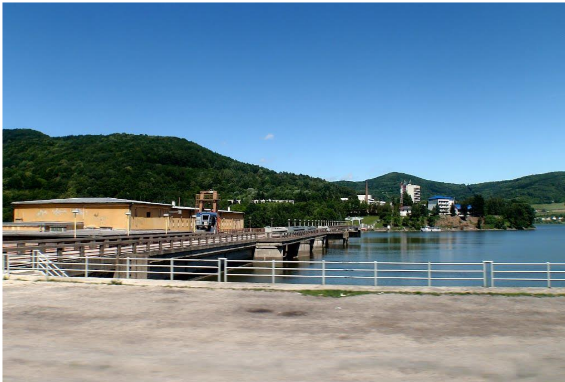
Obr. 13 Vodná elektrárň Považská Bystrica [37]
