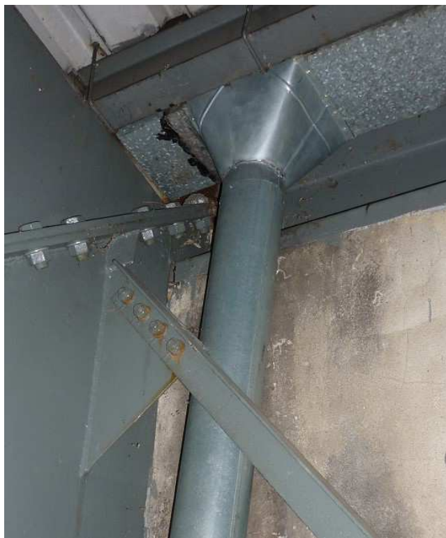
Obr. 9. Opravený svod.
