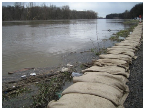
Obr. 18: Znárodnenie nedostatočnej výšky hrádze [29]
