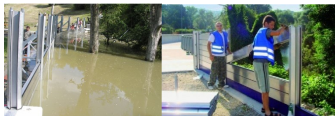
Obr. 21: Znážornenie použitia systému DPS 2000 [25]
