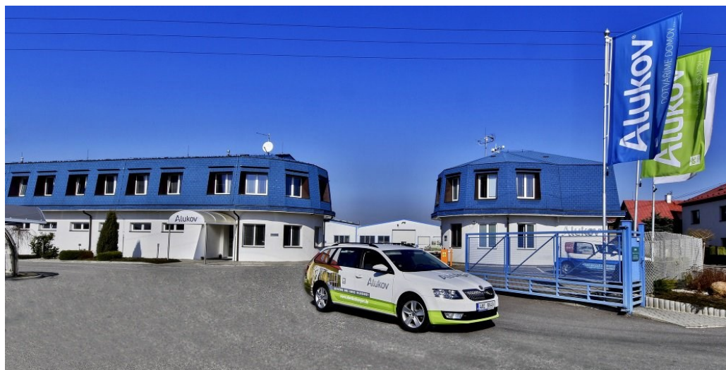
Abbildung 3: Das Firmenareal in Orel bei Chrudim
