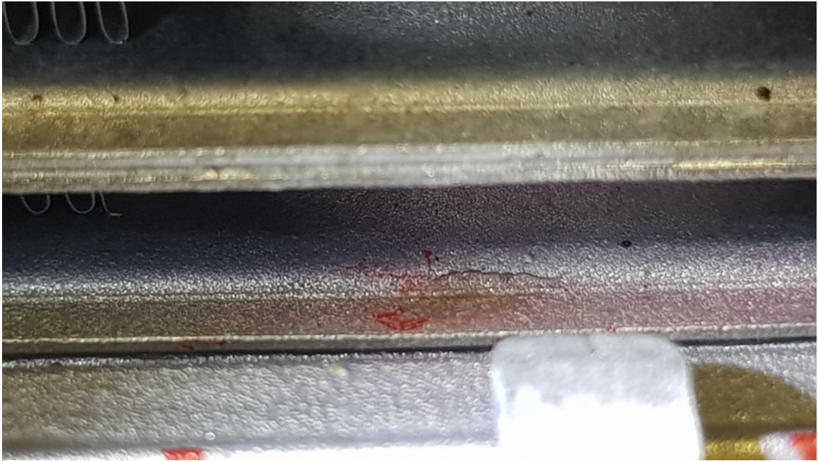
Obrázek 19 Detail cracku (Interní zdroj společnosti)
