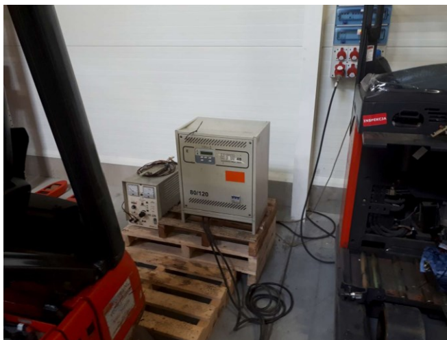
Obrázek 8 – Nevhodné umístění nabíjecí stanice [23]
