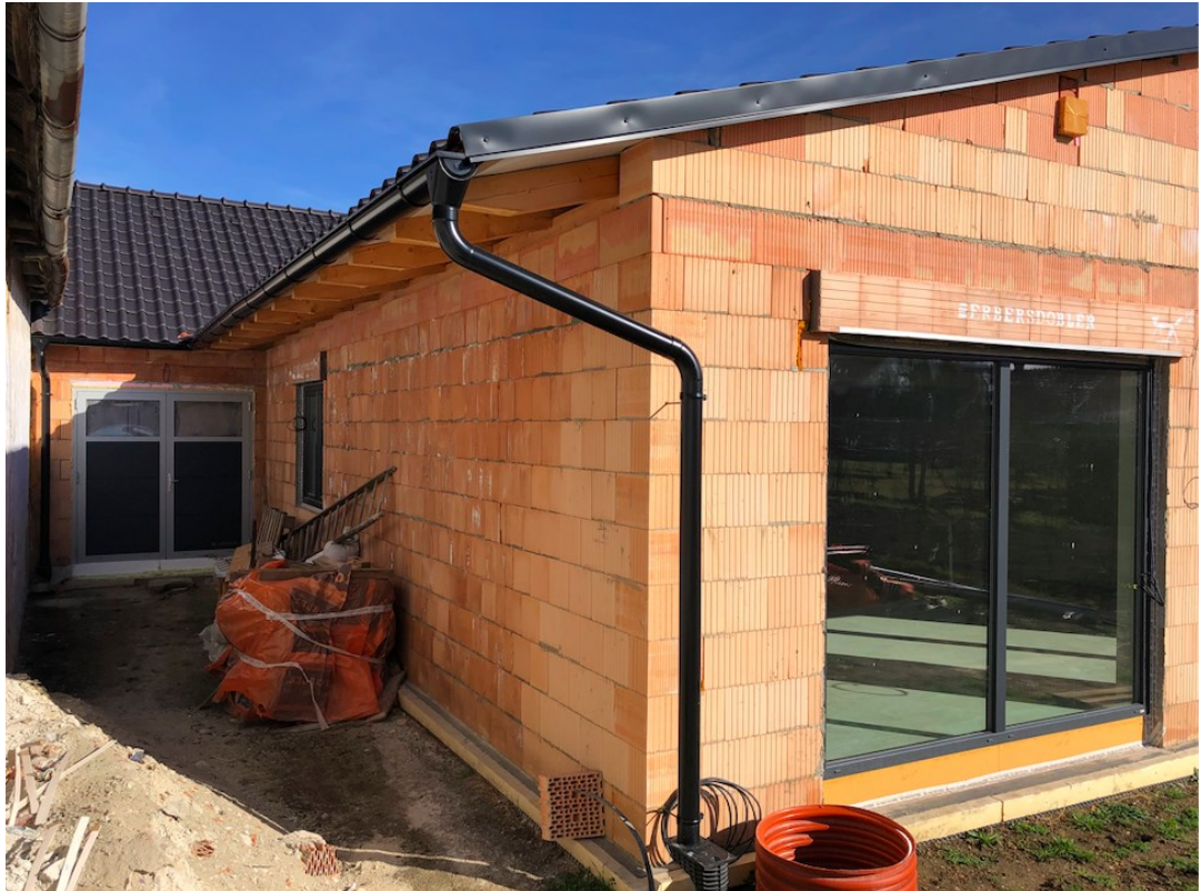
Obr. 22: Západní pohled na novostavbu rodinného domu
