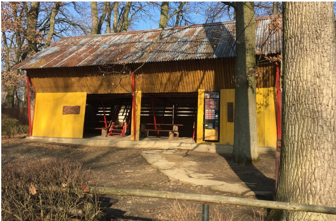
Obr. 5: Objekt podnikatelského záměru (vlastní fotografie)
