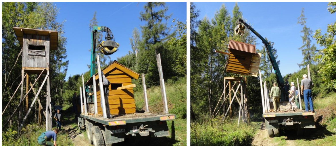
Obrázok 24 Výmena opotrebovanej kazateľne
