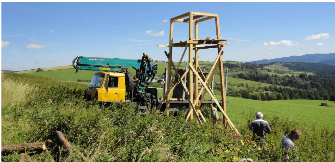
Obrázok 25 Výstavba nového posedu
