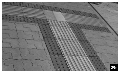
Obr. 29a Značení eskalátoru, Obr. 29b Značení schodů, Obr. 29c Značení tlačítek výtahu v Braillově písmu, Obr. 29d Možnosti vodících pásků na linii do interiéru, Obr. 29e Vodící linie exteriéru
