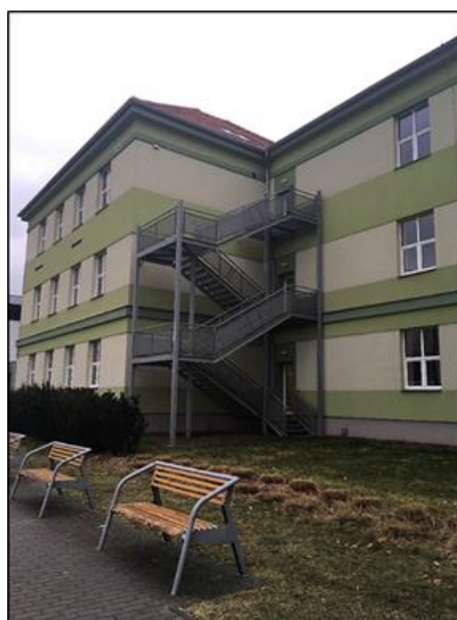
Obr. 6 Požární schodiště na budově UH1
