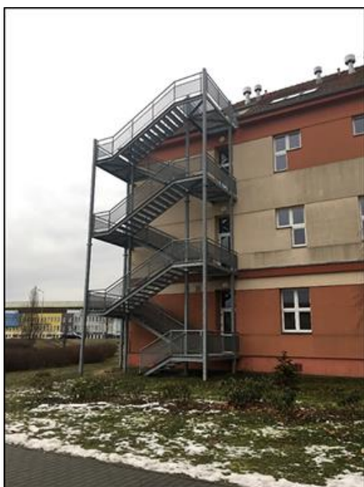
Obr. 5 Požární schodiště na budově UH5
