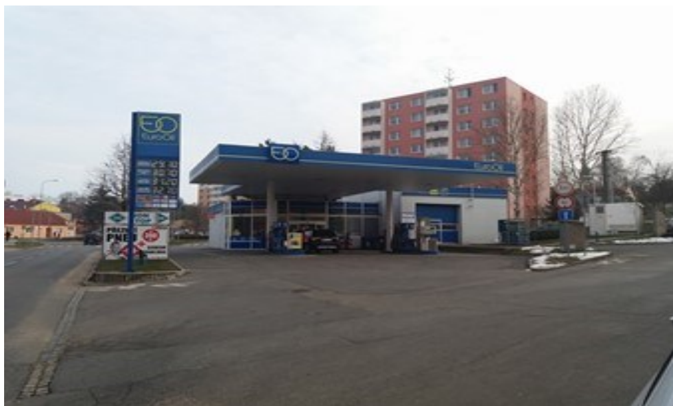
Obrázek 10: Čerpací stanice EuroOil Kyjov
