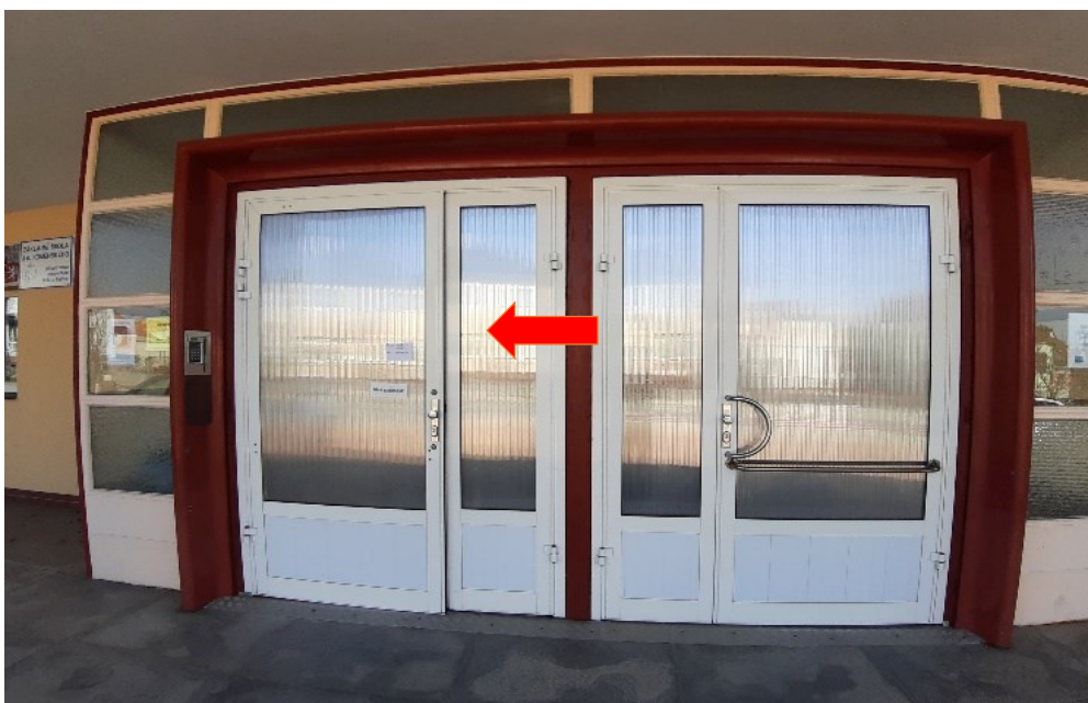
Obrázek 6: Vstup do ZŠ Újezd
